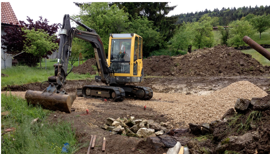
Travaux de terrassement en vue de la pose de deux containers © MCF
